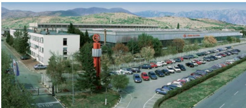
ZMM Sliven production plant
